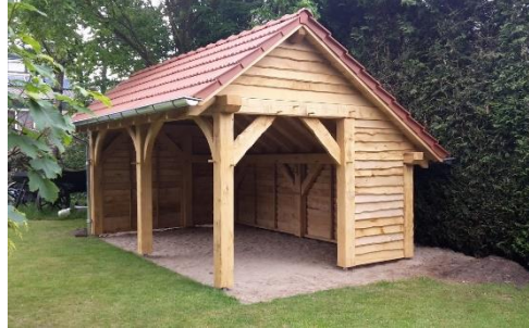
Kapschuur model. Achterzijde is lager dan de voorzijde, nokgording wordt uit het midden geplaatst
