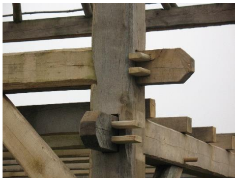
Authentieke ankerbalk verbinding
