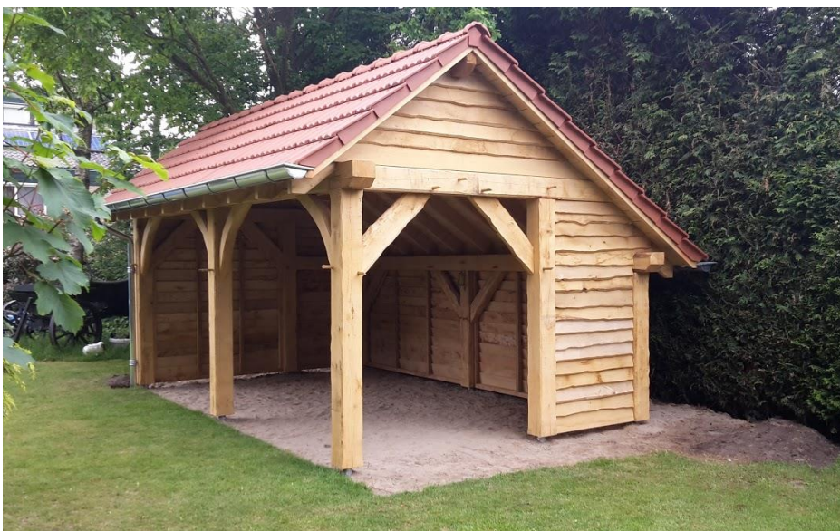
Kapschuurmodel, achterzijde is lager dan de voorzijde en de nokgording wordt geplaatst uit het midden
