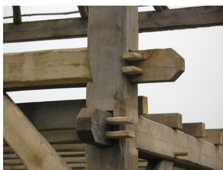
Authentieke ankerbalk verbinding
