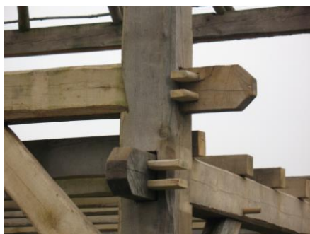
Authentieke ankerbalk verbinding
